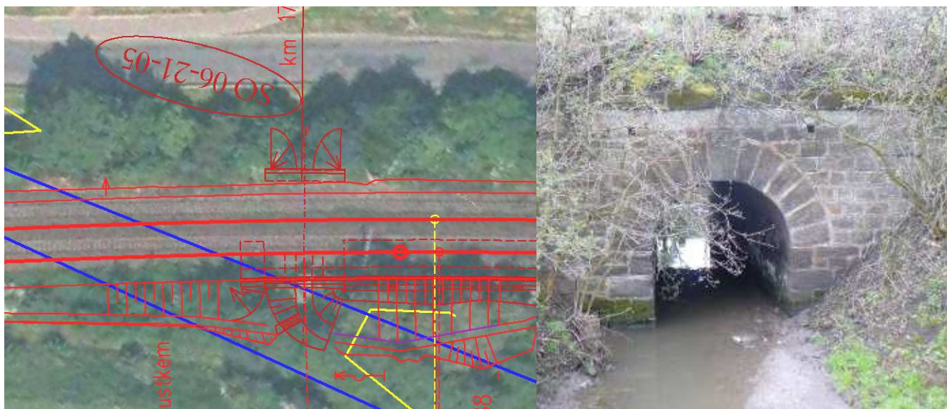
Obr. 12 SO 06-21-05 Mstětice - Praha Horní Počernice, propustek v ev. km 18,380 Stavbou prochází interakční prvek I6/337, dotčené území žst. Horní Počernice Stávající stav: vlevo deskový propustek sv. 2,0 m, vpravo kamenná klenba sv. 2,0 m, kamenná sp. st.
