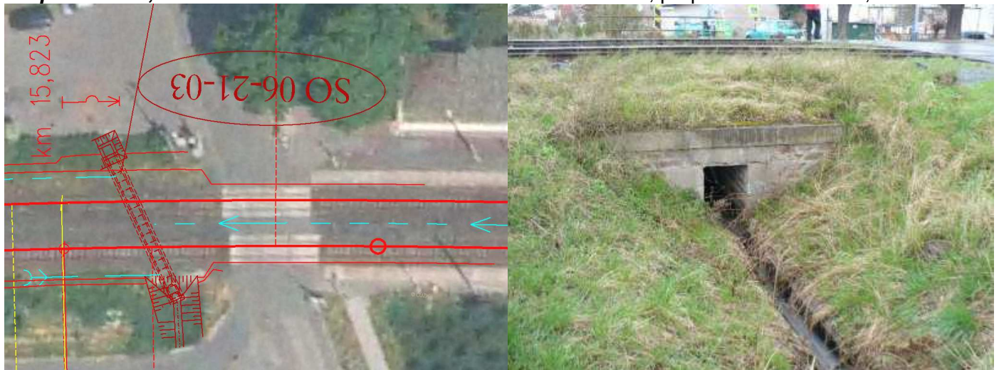
Obr. 11 SO 06-21-03, dotčené území Zeleneč, stávající stav: vlevo deskový propustek sv. 0,6m, vpravo trubní sv. 0,4 m
